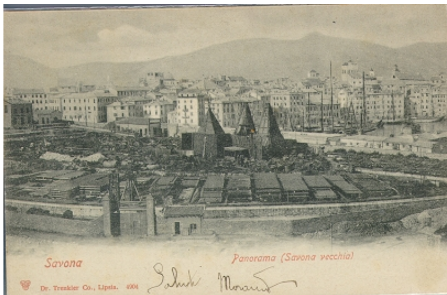
FIGURA 5. Veduta dell'insediamento industriale antecedente al 1902; in evidenza, al centro, i tre dispositivi ad urto per la frantumazione dei rottami di ghisa.
